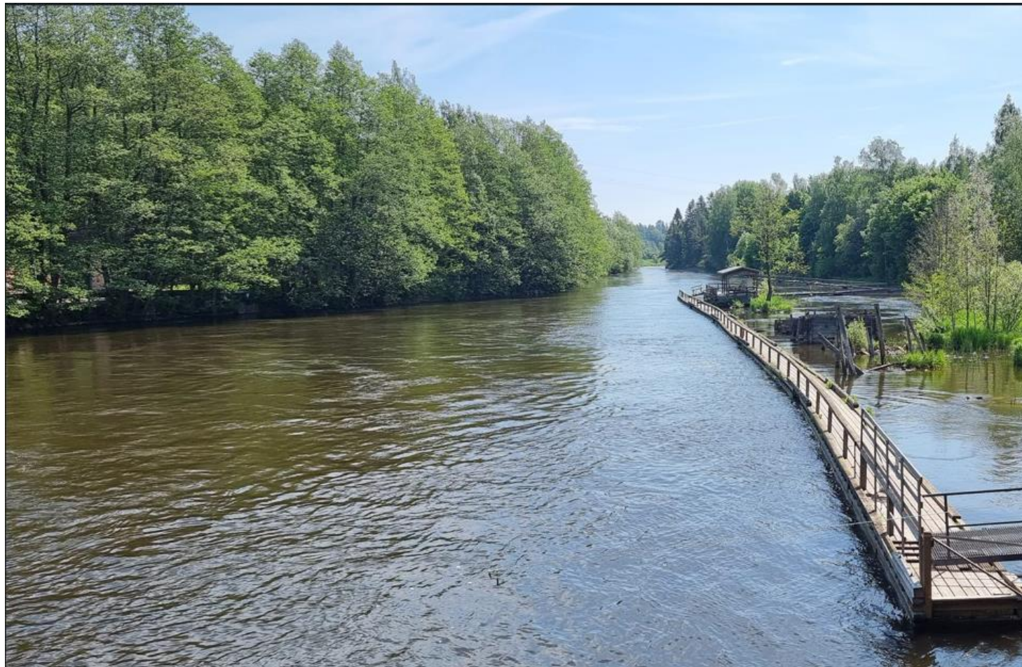
Korkeakosken voimalaitoksen alapuolinen laituri (Kuva: Mika Marttunen)
